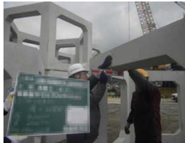
①出来形確認状況
