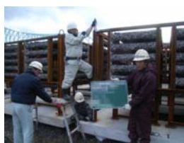
⑧出来形確認状況
