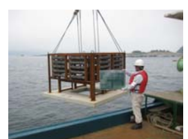
⑧沈設確認状況
