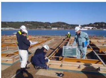
④魚礁ブロック基礎コンクリート型枠鉄筋組立確認状況
