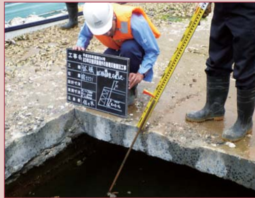
▲工事の施工管理
