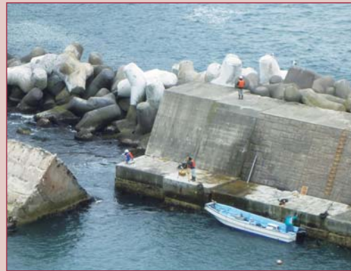
▲被災状況の調査
