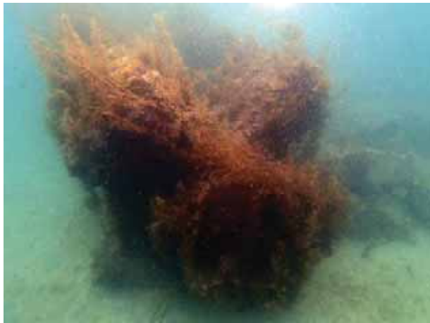
N-1_27 異型ブロック-南東端
